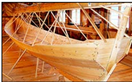
"Hjelmkonå" under bygging på Husa-notra i Valsøyfjord. Kyrkjebåten er vel 10 meter lang og har plass til 14 roarar. Midlane er skaffa ved gaver og dugnad.
